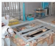
完成した枠に吊金物を取り付けます。
